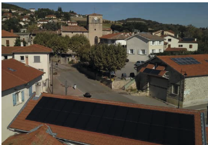
Centrale de 9 kWc installée sur la bibliothèque de Chaussan
