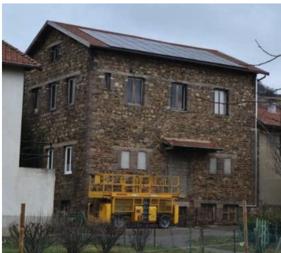
Travaux sur l'école primaire de Sainte Catherine
