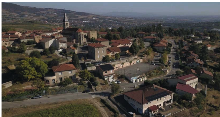
3 installations photovoltaïques de 9 kWc chacune sur des toitures du village de Rontalon : au premier plan, sur la brasserie "la Soyeuse", au deuxième plan sur le local technique municipal, et au troisième plan, sur la salle des fêtes
