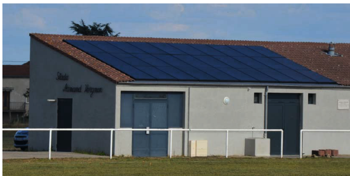
Centrale de 9 kWc installée sur le local foot de Saint Jean de Touslas (Beauvallon)
