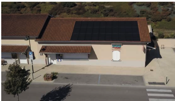
Centrale de 9 kWc installée sur l'épicerie (bâtiment communal) de Sainte Catherine
