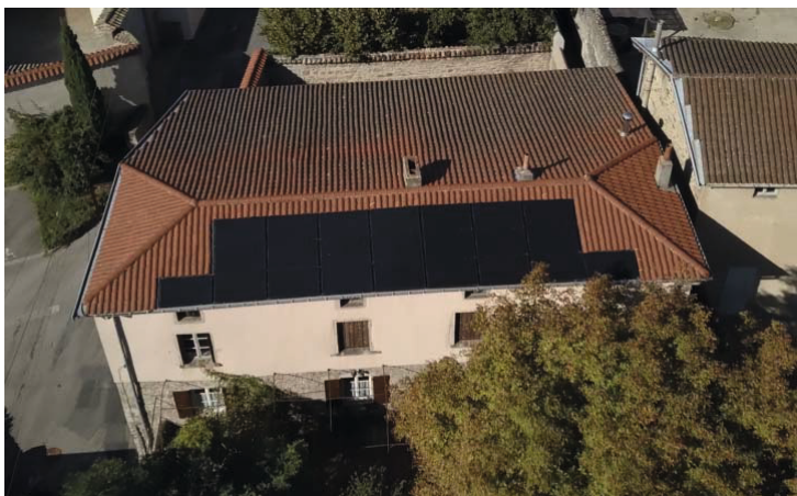
Centrale de 9 kWc installée sur l'école de musique de Saint Laurent d'Agy
