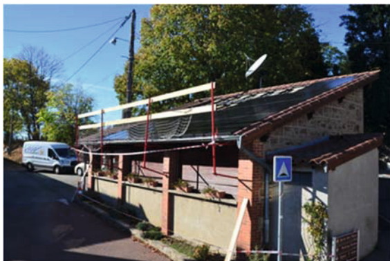
Travaux à Saint André La Côte - salle de réunion
