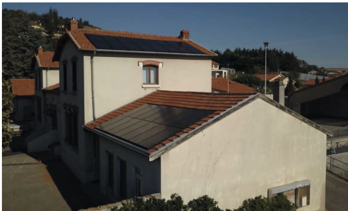
Centrale de 9 kWc installée sur deux pans sur l'école de Chaussan
