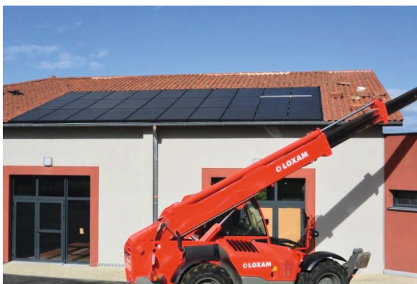
Travaux à Chassagny (Beauvallon) – salle des Varennes
