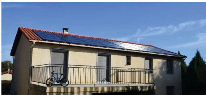
Centrale de 9 kWc installée sur une maison privée à Saint Maurice sur Dargoire (Chabanière)
