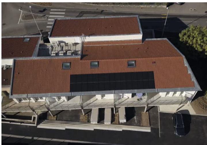
Centrale de 9 kWc installée sur la résidence séniors de Saint Laurent d'Agy
