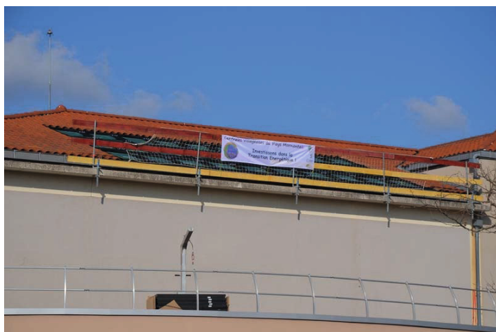
Travaux sur la salle Jean Carmet de Mornant, bâtiment propriété de la COPAMO
