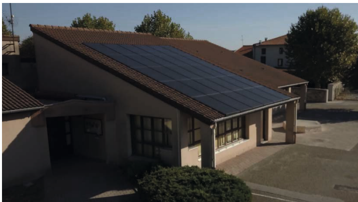
Centrale de 9 kWc installée sur l'école maternelle de Saint Andéol le Château (Beauvallon)
