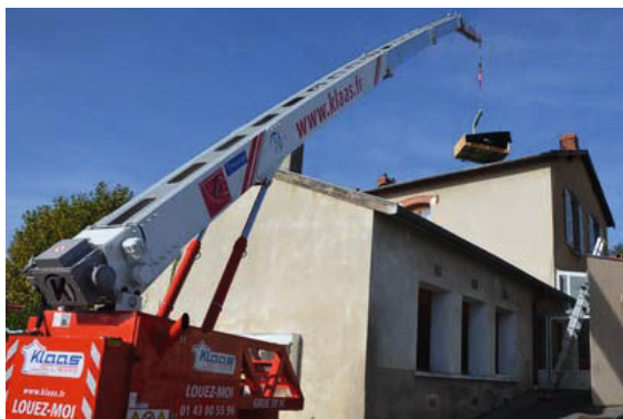
Travaux à Chaussan – école
