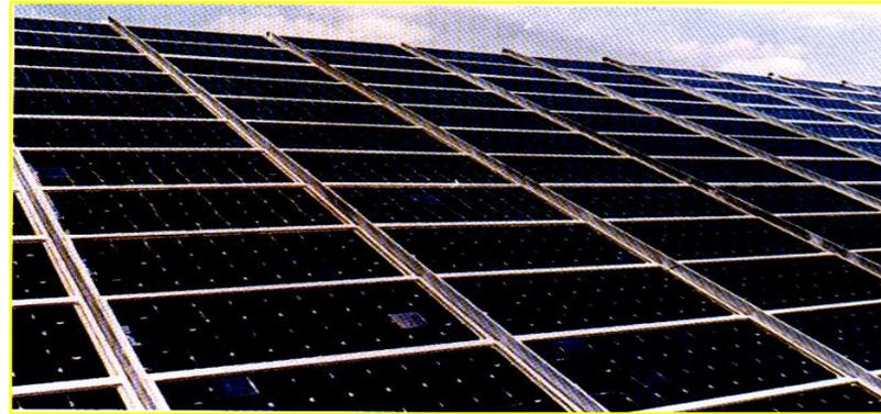
Pour augmenter la puissance, on groupe les modules PV en série/parallèle dans des champs PV
